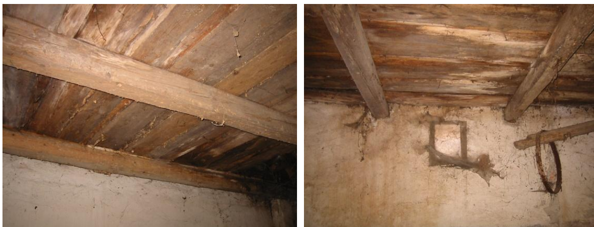
Slika 44 in 45: Strop v hlevu je lesen, stene pa zidane
