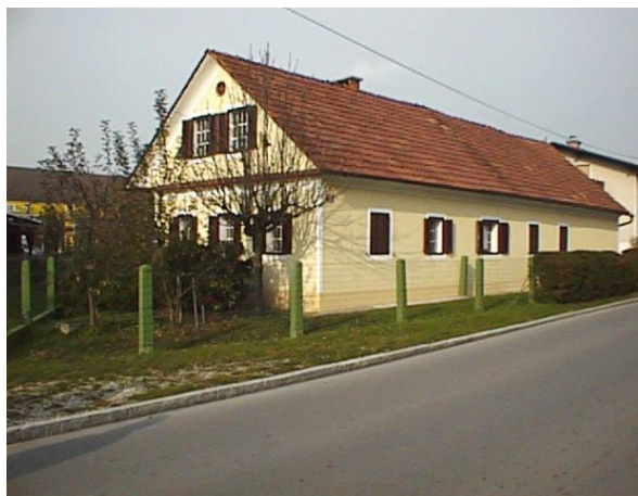
Slika 19: Koroščeva hiša na Rodici, pogled z jugozahodne strani
