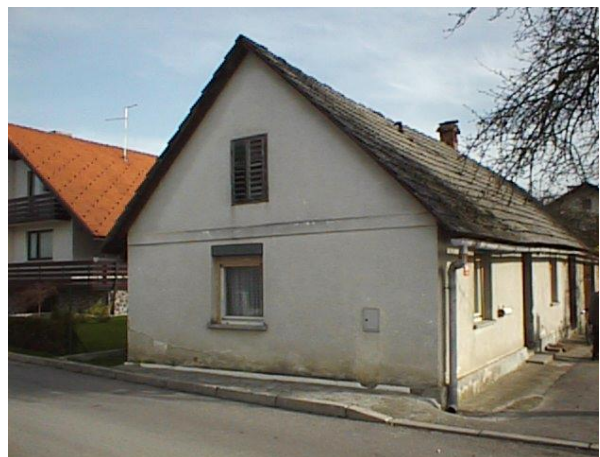
Slika 10: Šuštarjeva hiša, Rudniška 2, Srednje Jarše, pogled z jugozahodne strani
