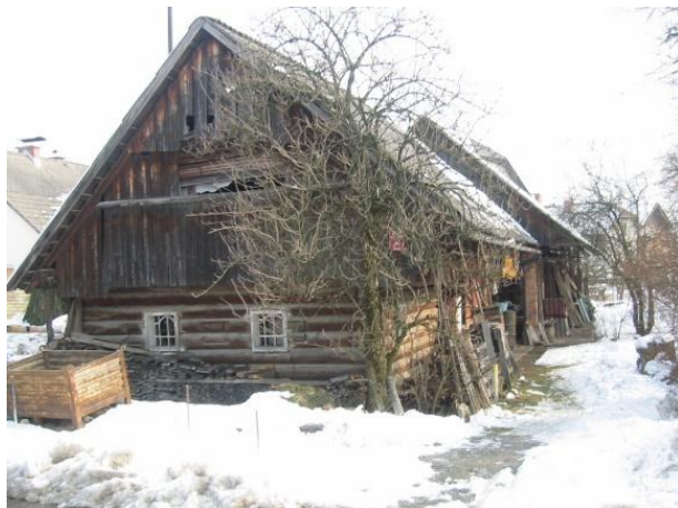
Slika 20: V zahodnem delu je Kofuntnikova hiša lesena. Nad okni je zatrepni gank.
