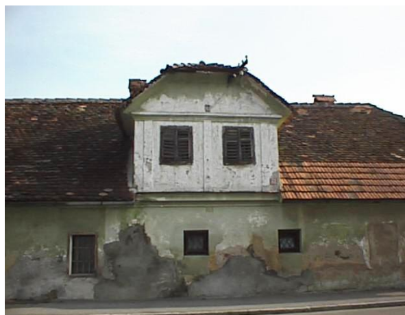
Slika 17: Pogled na nekdanjo Šmonovo hišo na Rodici z zahodne strani
