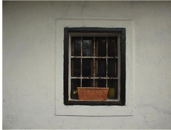
Slika 53: Okno Tomaževe hiše v Spodnjih Jaršah s kovinskimi rešetkami in obrobo
