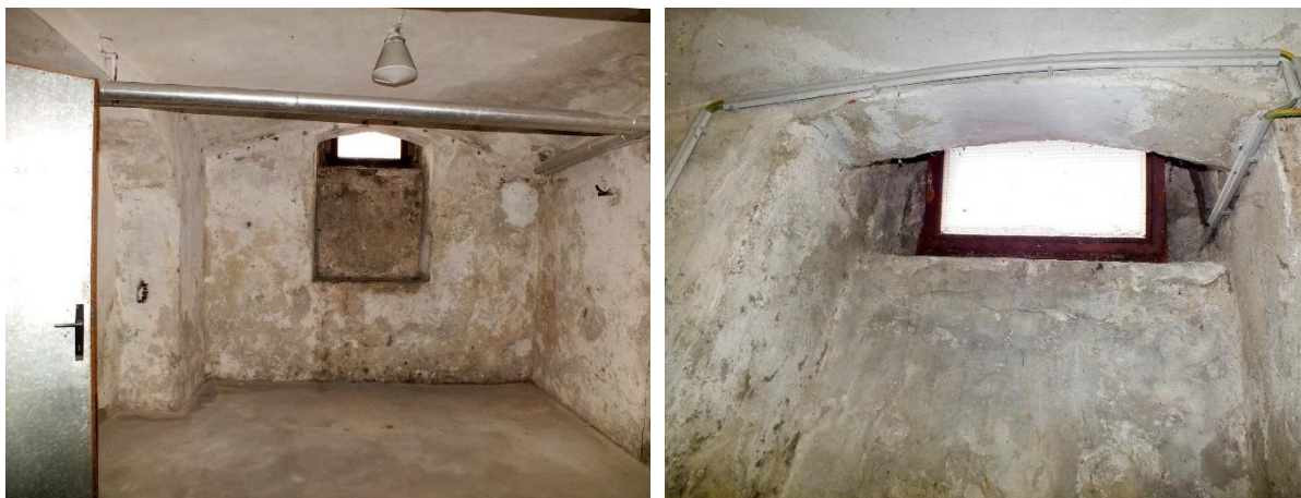
Sliki 13 in 14: Podkletena je le južna polovica šole. Posebno zanimiva so kletna okna.
