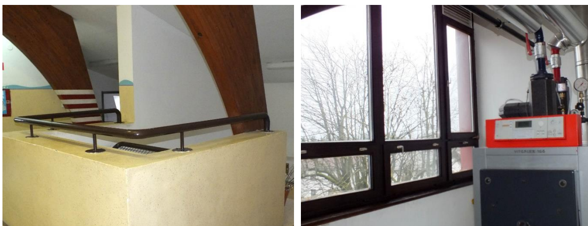
Sliki 41 in 42: Podstrešja šola danes nima več. Ograja v predelu stopnišča na vzhodni strani (levo) in plinska kotlovnica na južni strani (desno).
