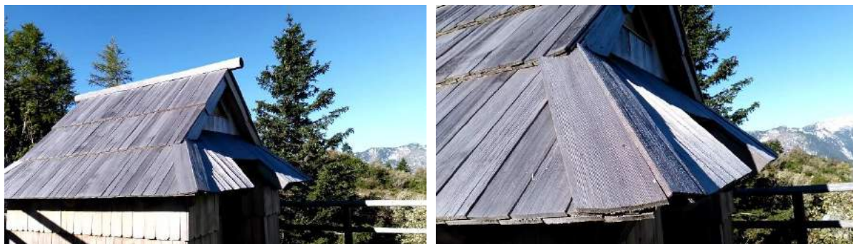
Sliki 101 in 102: Drvarnica je vedno štirioglata. Na robovih sta pribiti po dve deščici, ki se prekrivata. Drvarnica pri Rakovi bajti na Zelenem robu.
