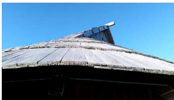
Slika 108: Skodle so položene v dve vrsti. V ozadju je vidno deblo, ki predstavlja sleme bajte, Jakšetova bajta na Šimnovcu.
