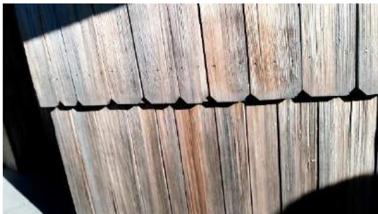
Slika 117: Skodle so oblikovane v konus, proti tlem se ožijo, kar je ravno obratno kot pri okrogli strehi.
