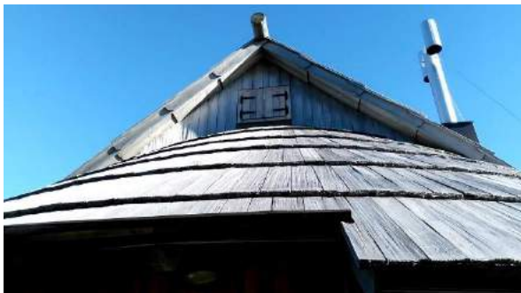
Slika 111: Trikotnik je zelo težko izdelati, saj moraš skodle žagati na različne dolžine, Naratova bajta na Šimnovcu.
