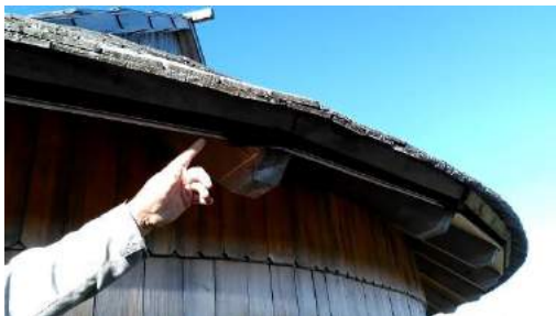
Slika 95: Spodnja stran strehe in zračni most.
