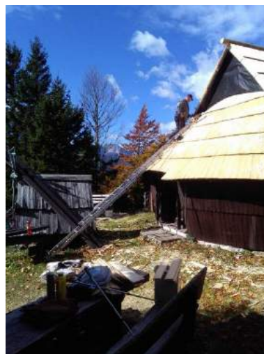
Sliki 91 in 92: Sin Jure Potočnik odstranjuje staro streho (levo). Franc Potočnik pokriva trikotni del nove strehe Jakšetove bajte na Šimnovcu, spomladi 2018 (foto: J. Potočnik).
