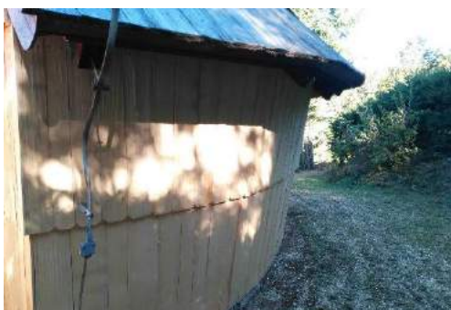
Slika 107: Fasada je narejena v »gobico« Ni narejena pravokotno, ampak se proti tlem oža. Naratova bajta na Šimnovcu.
