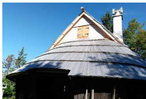
Slika 105 in 106: Okroglina s skrajšanimi skodlami in malo krivine nad vhodom, Rakova bajta na Zelenem robu (levo) in Jakšetova bajta na Šimnovcu (desno).
