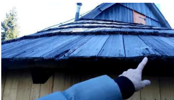
Sliki 20 in 21: Dotrajane skodle na strehah počitniških bajt Kekec in Ojstrica na Šimnovcu.
