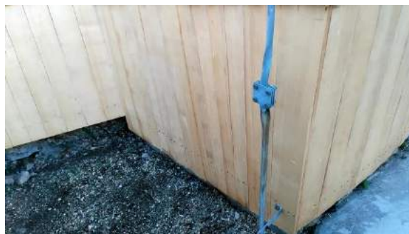
Slika 124: Strelovod je speljan v zemljo. Nov strelovod napeljuje električar, starega pa odstrani in na koncu obnove znova vgradi skodlar.
