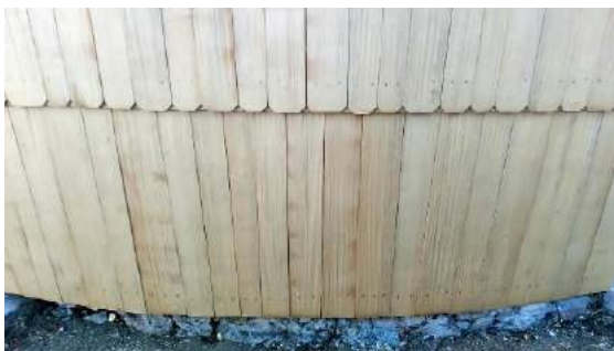
Slika 119: Spodnji rob zaključnih skodel je raven, Naratova bajta na Šimnovcu.
