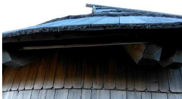
Slika 98: Skodle so položene v dve vrsti. Zgornja vrsta skodel prekrije reže spodnje vrste.
