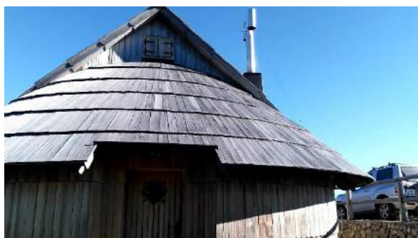
Slika 105 in 106: Okroglina s skrajšanimi skodlami in malo krivine nad vhodom, Rakova bajta na Zelenem robu (levo) in Jakšetova bajta na Šimnovcu (desno).
