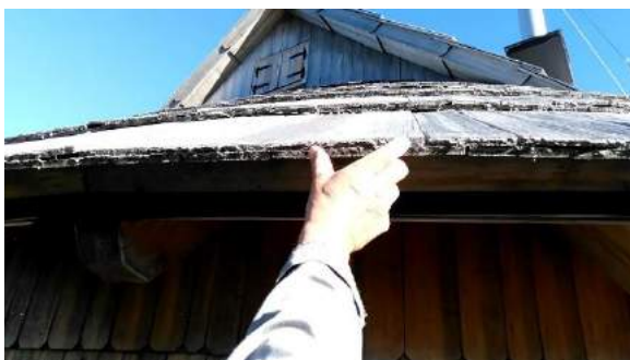
Slika 99: Skodle položimo v dve vrsti. Zgornja vrsta prekrije reže spodnje vrste. Naratova bajta na Šimnovcu.
