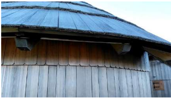
Slika 115: Fasada je obnovljena, streha pa še čaka na obnovo, Naratova bajta na Šimnovcu.
