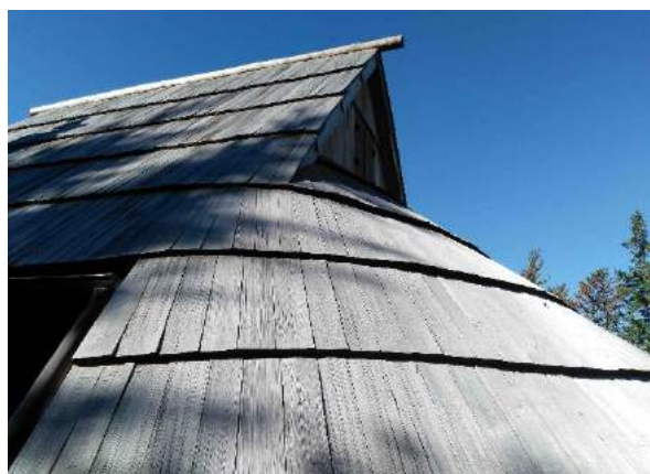
Slika 110: Na vrhu strehe se položi sleme, Jakšetova bajta na Šimnovcu.
