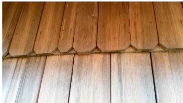
Slika 116: Robove skodel v fasadi skodlar požaga, da doseže lepši estetski izgled.
