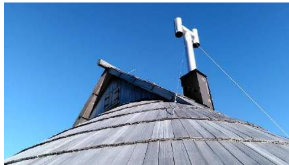
Slika 112: Dimnik se pritrdi še z vrvmi, da ne pade in uniči strehe, Jakšetova bajta na Šimnovcu.
