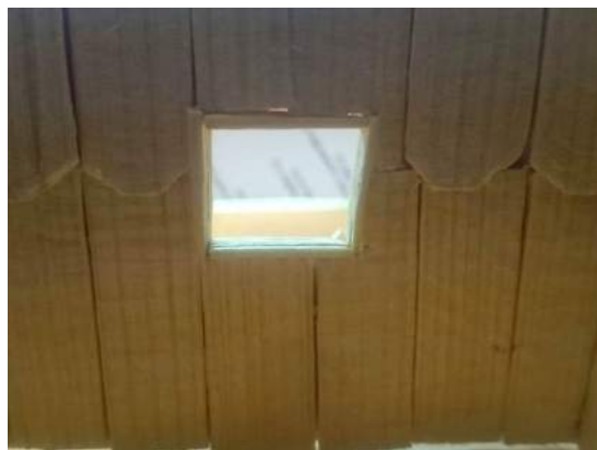
Slika 148: Na okno na fasadi nalepimo tanjše skodle, ki smo jih razklali in narezali na manjše dele, da je okno lepše zaključeno.
