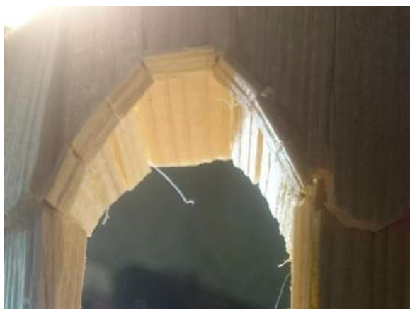
Slika 149: Pri vratih dodamo še nekaj skodel, ker je fasada narejena v konus. Vrata morajo biti postavljena navpično, da se lahko odpirajo.
