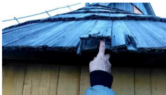
Sliki 20 in 21: Dotrajane skodle na strehah počitniških bajt Kekec in Ojstrica na Šimnovcu.
