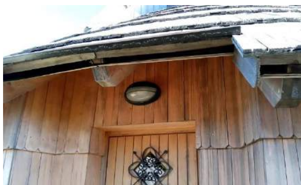
Slika 121: Vrata naredi mizar, vgradi pa jih skodlar, Rakova bajta na Zelenem robu.
