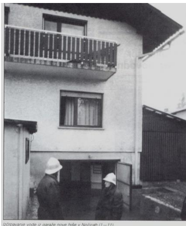
Črpanje vode iz garaže nove hiše v Nožicah ob poplavi leta 1990
