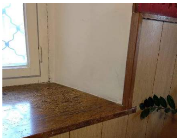
Sliki 71 in 72: Okenska odprtina je razširjena v prostor, zaradi česar v prostor pride veliko svetlobe. Desno: Okenske police so iz lehnjaka. V spodnjem delu so stene v dnevni sobi obdane z lesenim opažem.
