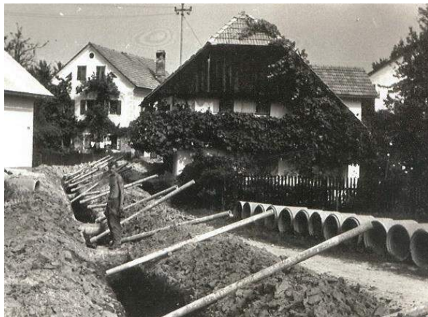
Slika 23: Gradnja kanalizacije pred Žmajdovo hišo okoli leta 1961 (arhiv Alenke Pavlin).
