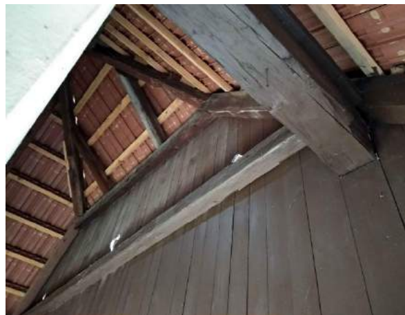
Sliki 107 in 108: Lesena konstrukcija z lesnim opažem nad gankom v predelu čopa (na južni strani hiše). 46
