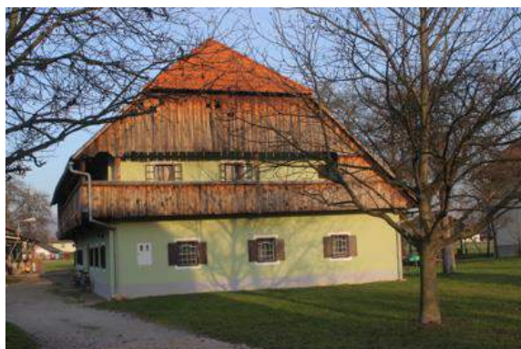
Slika 10: Žmajdovi hiši je podobna hiša Pri Krivc v Dobu (ID 1-13894). V Registru je opisana takole: »Kmečka hiša iz 1829 z majhnimi okni s kovanimi mrežami in lesenimi polkni ter z zaprtim lesenim zatrepnim gankom, podaljšanim do vhoda na severozahodni steni hiše.« 36
