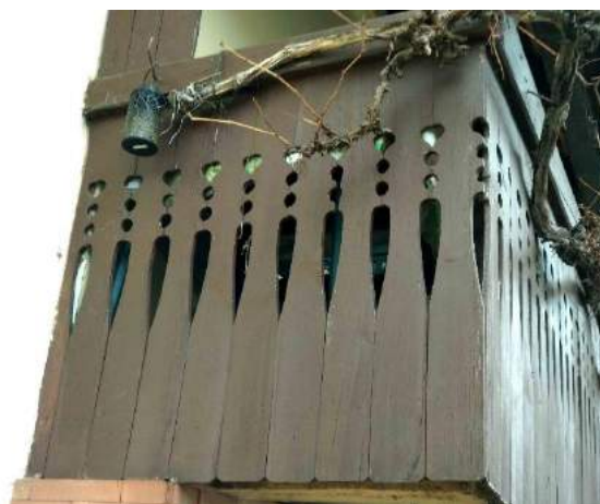
Sliki 45 in 46: Betonsko ploščo na ganku omejujejo leseni tramovi. Klinker ploščice pa so položene do betonske plošče (levo). Severna stranica ganka nad cesto, kotne letvice so umetelno zložene tako, da se izrezljani vzorec lepo sklada.
