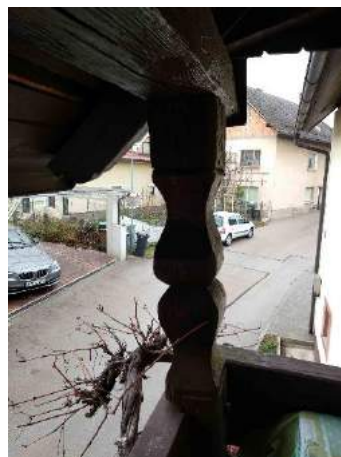
Sliki 103 in 104: Stebri, ki so del originalne konstrukcije, so bili že prvotno lepo oblikovani.
