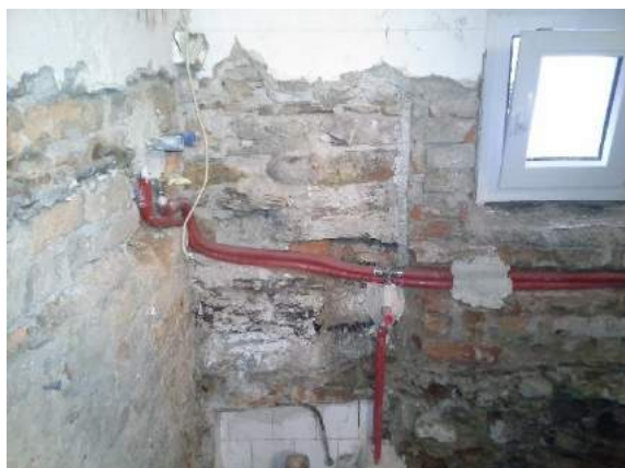
Sliki 31 in 32: Material v zidovju nekdanjega hleva se je razkril ob prenovi kopalnice leta 2016. Spodaj vidimo kamnito gradivo, zgoraj pa opeko. Betonski tlak je premazan z bitumensko hidroizolativno maso (arhiv Zorana Pavlina). Stene v predelu dnevne sobe so še v celoti kamnite.
