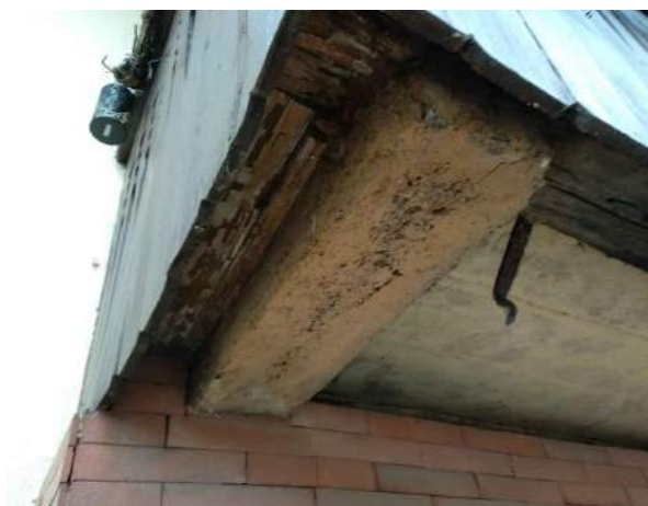
Sliki 47 in 48: Na skrajnem severnem delu ganka je lesen tram v slabem stanju. Poleg njega je betonska preklada in betonska plošča, do katere so položene klinker ploščice (levo). Nekdanja zelena polkna brez okraskov so bila leta 1978 zamenjana s sedanjimi. Izrezljani srčki so enaki kot v ganku (desno).
