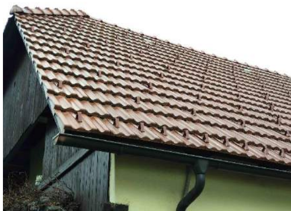
Sliki 53 in 54: Nova strešna opeka Tondach in novi žlebovi, ki sta jih Alenka in Zoran Pavlin leta 2013 zamenjala s starimi. Žlebovi so iz eloksiranega aluminija. 45
