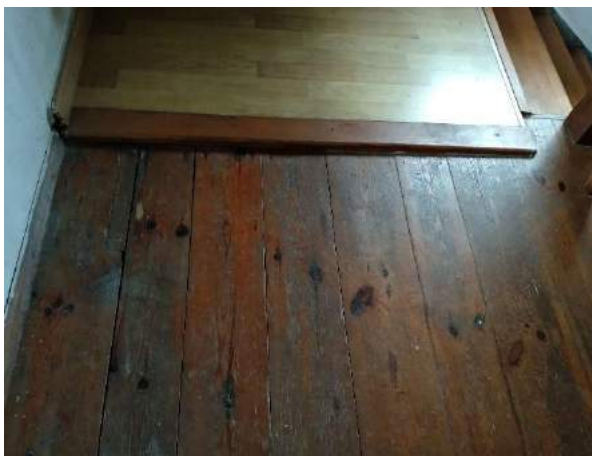
Sliki 87 in 88: Originalni leseni tlak, v katerem so verjetno tramovi z vmesnim peskom, na katere so položene deske. Stopnišče in predprostor sta svetla, saj sta tukaj vgrajeni dve okni.
