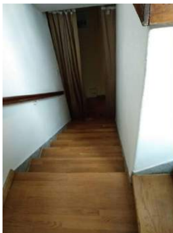
Sliki 85 in 86: Stopnice v prizidku so betonske in obložene z lesom.
