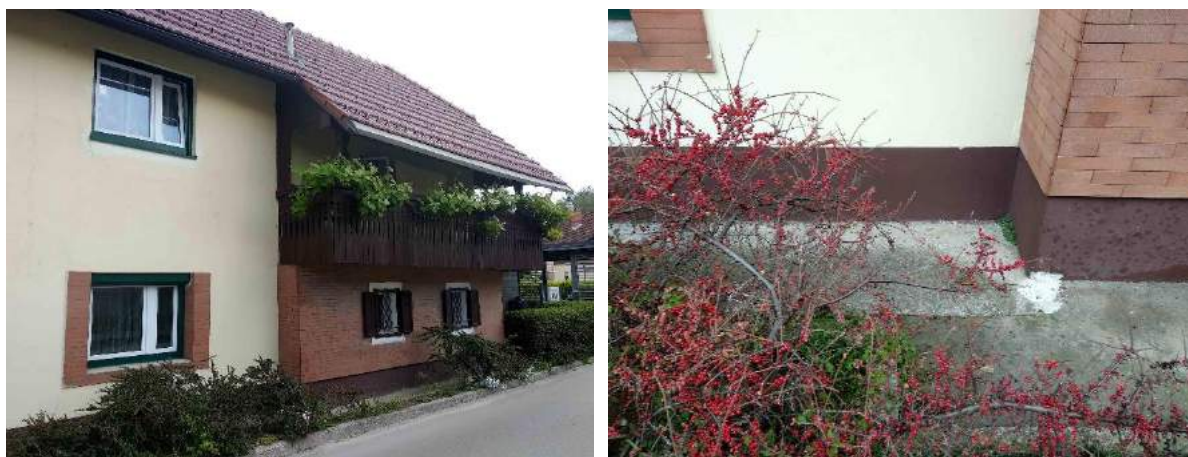
Sliki 61 in 62: Okni v kuhinji in spalnici sta iz leta 2015 (levo) in originalna okna z gavtri pod gankom v starejšem, južnem delu Žmajdove hiše. Desno: Južni del hiše, ki je obložen s klinkerjem, je širši od ostale hiše. Debelina zidu v južnem delu je 76 cm, v severnem pa 73 cm.
