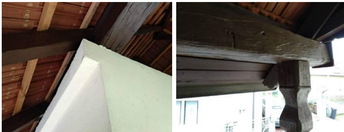
Sliki 109 in 110: Tramovi so položeni na betonsko ploščo nad Žanovo spalnico. Desno: stik stebra s strešnim tramom, ki je na koncu okrašen z okrasno deščico (na desni).
