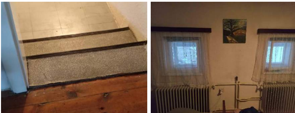
Sliki 91 in 92: S starega podesta vodita dve stopnici proti predelu nad dnevno sobo, kjer so naredili betonsko ploščo. Strop v dnevni sobi je 23 centimetrov nižji kot v kuhinji. Desno: majhna okna v nekdanji Žanovi sobi.
