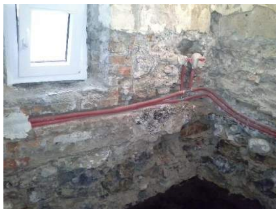
Sliki 31 in 32: Material v zidovju nekdanjega hleva se je razkril ob prenovi kopalnice leta 2016. Spodaj vidimo kamnito gradivo, zgoraj pa opeko. Betonski tlak je premazan z bitumensko hidroizolativno maso (arhiv Zorana Pavlina). Stene v predelu dnevne sobe so še v celoti kamnite.
