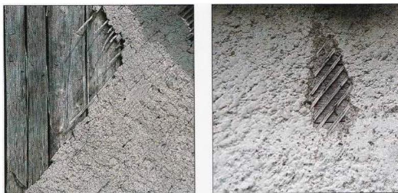
Slika 11: Omet iz apnene malte, ometan na trstiko (levo) ali na lesene letvice (desno). 38
