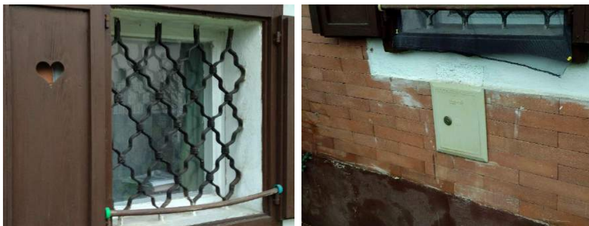
Sliki 49 in 50: Kovinske mreže so zelo stare, saj jih niso nikoli menjali (levo). Okna so obrobljena z belim robom iz prvotnega ometa, do katerega so položene klinker plošče. Cokel je pobarvan z rjavo barvo (desno).
