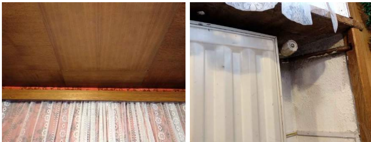
Sliki 73 in 74: V dnevni sobi so stene nad lesenim opažem obložene z rdečimi papirnatimi tapetami, strop pa z lesenimi ploščami, ki jih je položil mizar Peter Juvan iz Domžal. Desno: Pod lesenim opažem in tapetami je apneni omet.
