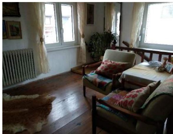
Sliki 87 in 88: Originalni leseni tlak, v katerem so verjetno tramovi z vmesnim peskom, na katere so položene deske. Stopnišče in predprostor sta svetla, saj sta tukaj vgrajeni dve okni.
