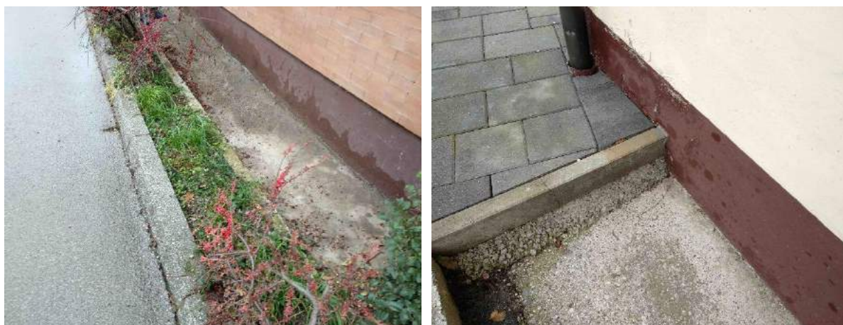
Sliki 63 in 64: Na levi sliki je viden dvignjen robnik ob robu ceste in odtočni kanal ob robu hiše. Desno: Odtok deževnice s strehe, ki se pod površjem steka v kanalizacijo.
