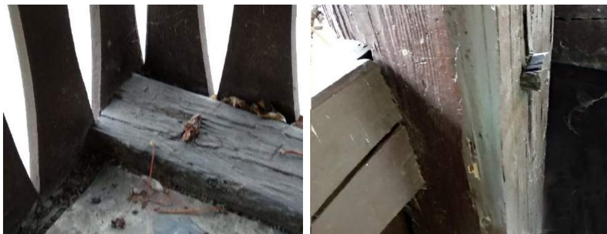
Sliki 101 in 102: Zaključni del originalnega trama na južni strani. Desno: Stara lesena konstrukcija je povezana z lesenimi žebli.
