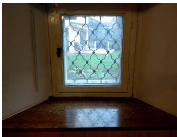
Sliki 71 in 72: Okenska odprtina je razširjena v prostor, zaradi česar v prostor pride veliko svetlobe. Desno: Okenske police so iz lehnjaka. V spodnjem delu so stene v dnevni sobi obdane z lesenim opažem.
