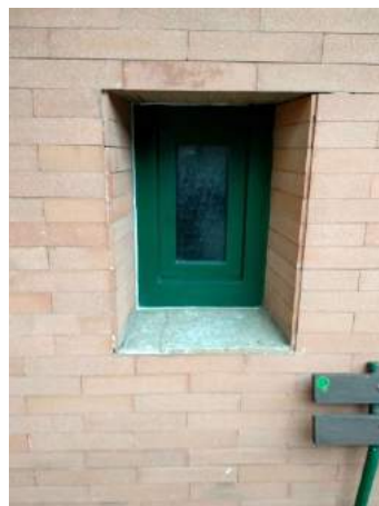
Sliki 55 in 56: Ta vhodna vrata so bila nameščena leta 2015. Pred tem so bila vzhodna vrata brez okraskov (levo). Vhodna vrata so obdana z oblogo iz klinkerja, ki se nadaljuje do straniščnega okna (desno).
