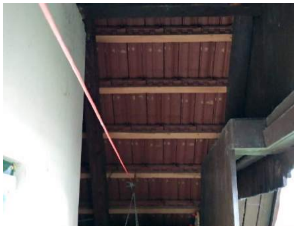
Sliki 107 in 108: Lesena konstrukcija z lesnim opažem nad gankom v predelu čopa (na južni strani hiše). 46
