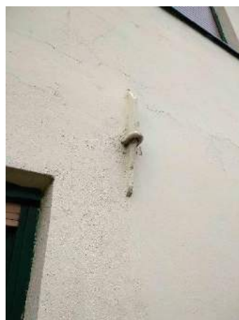
Sliki 59 in 60: Severna fasada Žmajdove hiše z manjšim kuhinjskim oknom in večjim oknom nekdanje otroške spalnice (levo). Na desni sliki je vidna železna horizontalna vez, ki skrbi za večjo stabilnost in protipotresno varnost hiše.
