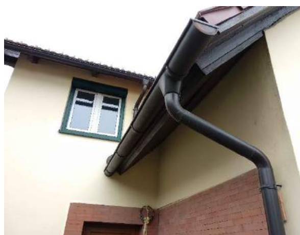
Sliki 53 in 54: Nova strešna opeka Tondach in novi žlebovi, ki sta jih Alenka in Zoran Pavlin leta 2013 zamenjala s starimi. Žlebovi so iz eloksiranega aluminija. 45
