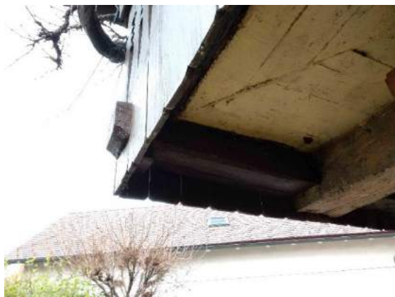
Sliki 43 in 44: Pogled na gank od spodaj. Vidi se betonska plošča in betonska preklada, 44 ki so z zunanje strani obdane z lesom (levo). Na desni sliki vidimo stik lesenih tramov z ometom.
