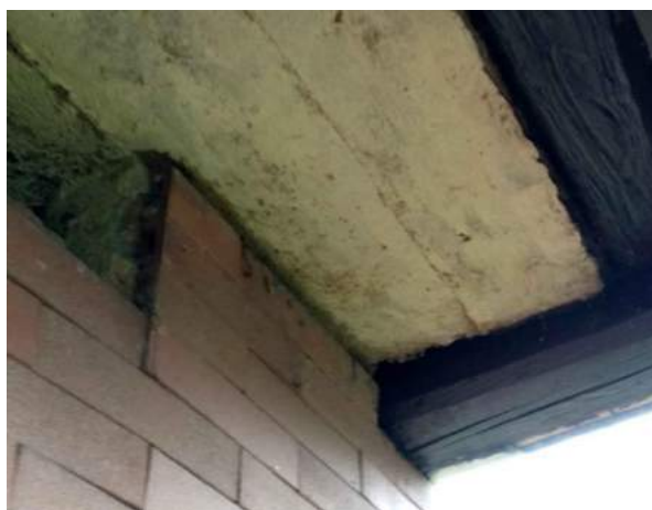
Sliki 45 in 46: Betonsko ploščo na ganku omejujejo leseni tramovi. Klinker ploščice pa so položene do betonske plošče (levo). Severna stranica ganka nad cesto, kotne letvice so umetelno zložene tako, da se izrezljani vzorec lepo sklada.
