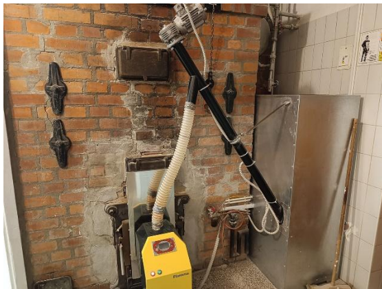
Sliki 37 in 38: Kurišče današnje peči za peko kruha z gorilec (levo) in kovinsko posodo za pelete (desno).
